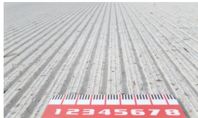
(d) Finished construction
