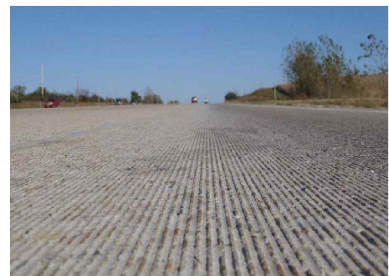
(d) Finished construction
